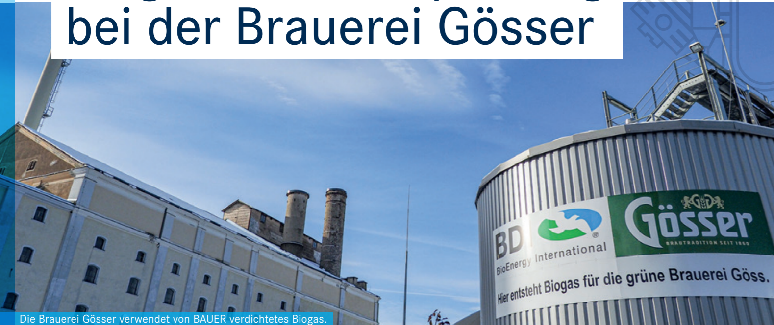
Die Brauerei Gösser verwendet von BAUER verdichtetes Biogas.
